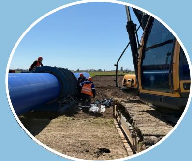
В рамках федеральной программы продолжается строительство и модернизация КНС №6 в Керчи. Все пусконаладочные работы завершены. Канализационная насосная станция, оснащенная современным автоматизированным оборудованием и четырьмя автономными насосными группами, введена в эксплуатацию. Для полного окончания работ необходимо завершить строительство резервуара, выполняющего все функции автономно в аварийных ситуациях. Полностью сдать готовый объект планируется к концу 2025 года.
